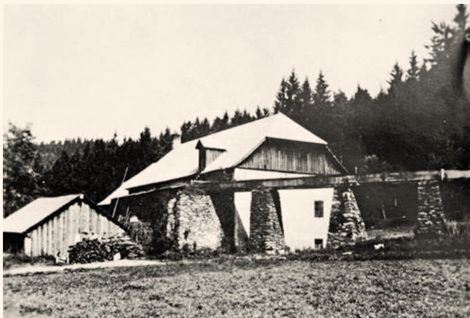
Lísková, brusírna č.p. 25, zvaná Stich Werk položená v údolí Černého potoka. Pro Stich Werk byl charakteristický akvadukt, přivádějící vodu na kolo.
